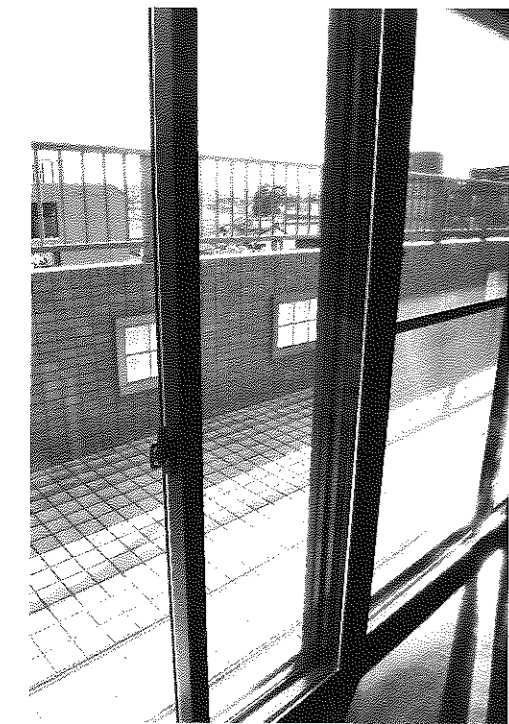
▲二重窓(ガラスは三重)は窓面の強化にもつながるほか、紫外線による床色の変色なども防いでいる
