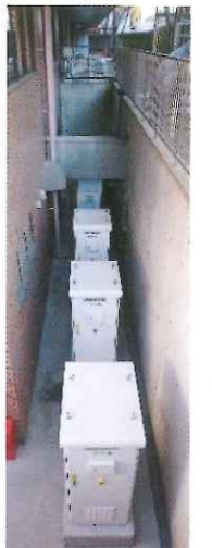
ドライエリアに設置した130kwhの4台の大型蓄電池
